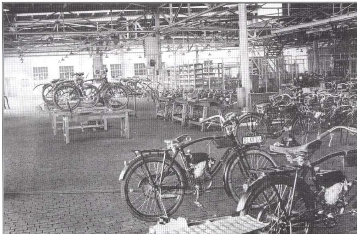
Montážní hala prvních motokol ČZ v letech 1932–35. V popředí ČZ 76 – „Kaktus“
